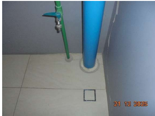
ก๊อกน้ำและท่อระบายน้ำห้องพักมูลฝอย
