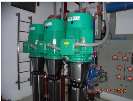
ระบบสูบน้ำขึ้นใต้ดิน
