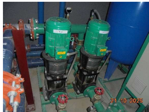
ระบบสูบน้ำขึ้นคาตฟ้า
